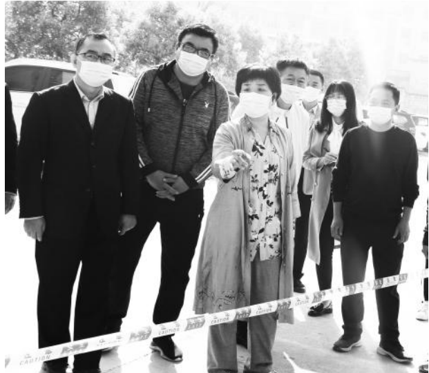
县委书记刘中英(前排中间)在玉立花园小区燃气管道改造工程进展现场
